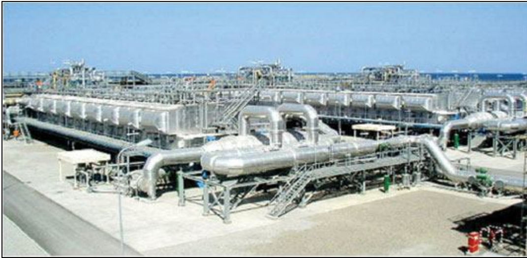
Εγκατάσταση πολυβάθμιας εκτόνωσης στη Μέση Ανατολή
