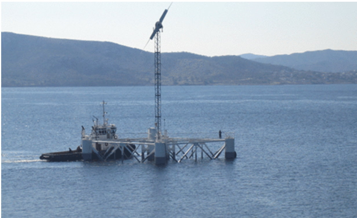
Σχήμα 4.11 Πλωτή μονάδα αφαλάτωσης εγκατεστημένη στην Ηρακλεία
