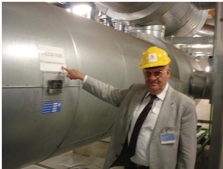
Σχ. 17: Ο ένας από τους τέσσερις Εναλλάκτες που χρησιμοποιούνται στο ΣΑΘ για την προθέρμανση του Συμπυκνώματος
