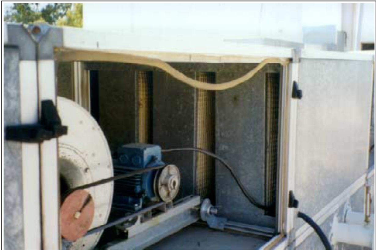
Εικόνα Α.4-7β: Φίλτρα αέρα τοποθετημένα στο εσωτερικό της AHU που εξυπηρετεί χειρουργεία.
