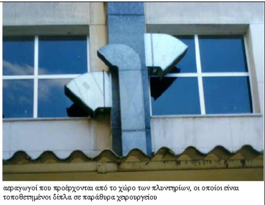
Εικόνα Α.7-2: λανθασμένα παραδείγματα σχετικά με τη χρήση παραθύρων
