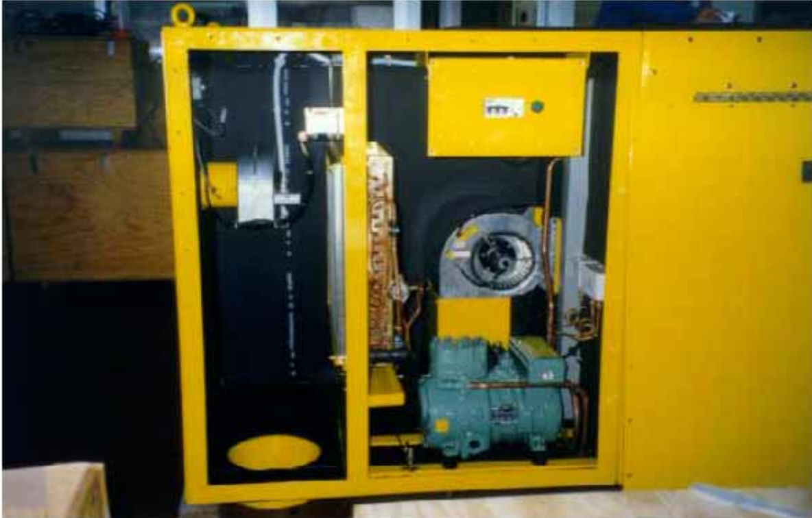
Εικόνα Α.4-21: Μία μικρή AHU που έχει αφαιρεθεί το πλαϊνό πλαίσιο για να αποκαλυφθούν τα φίλτρα, οι ανεμιστήρες, οι εναλλάκτες θερμότητας και για να είναι εύκολη η συντήρηση
