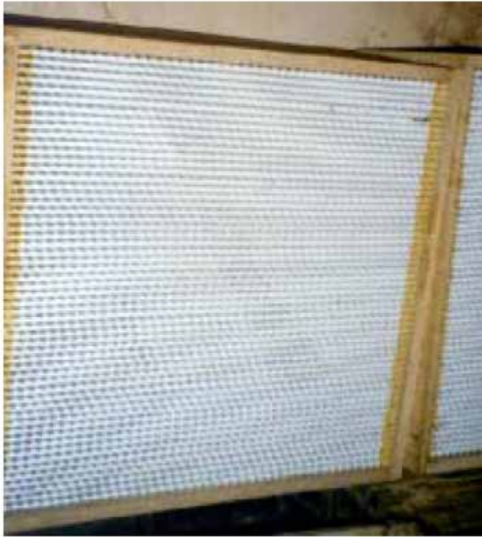
Εικόνα Α.4-8: Επιφάνεια ενός απόλυτου φίλτρου με απόδοση 99,999%
