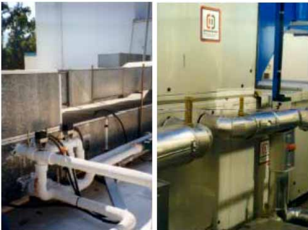
Εικόνα A.4.5-α: Σωλήνες που συνδέονται με την ΑΗU και βρίσκονται σε καλή κατάσταση
