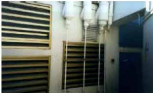
Εικόνα A.4-19: Ρυθμιζόμενες βάνες προσαρμογής που προσαρμόζουν τη ροή του διερχόμενου αέρα.
