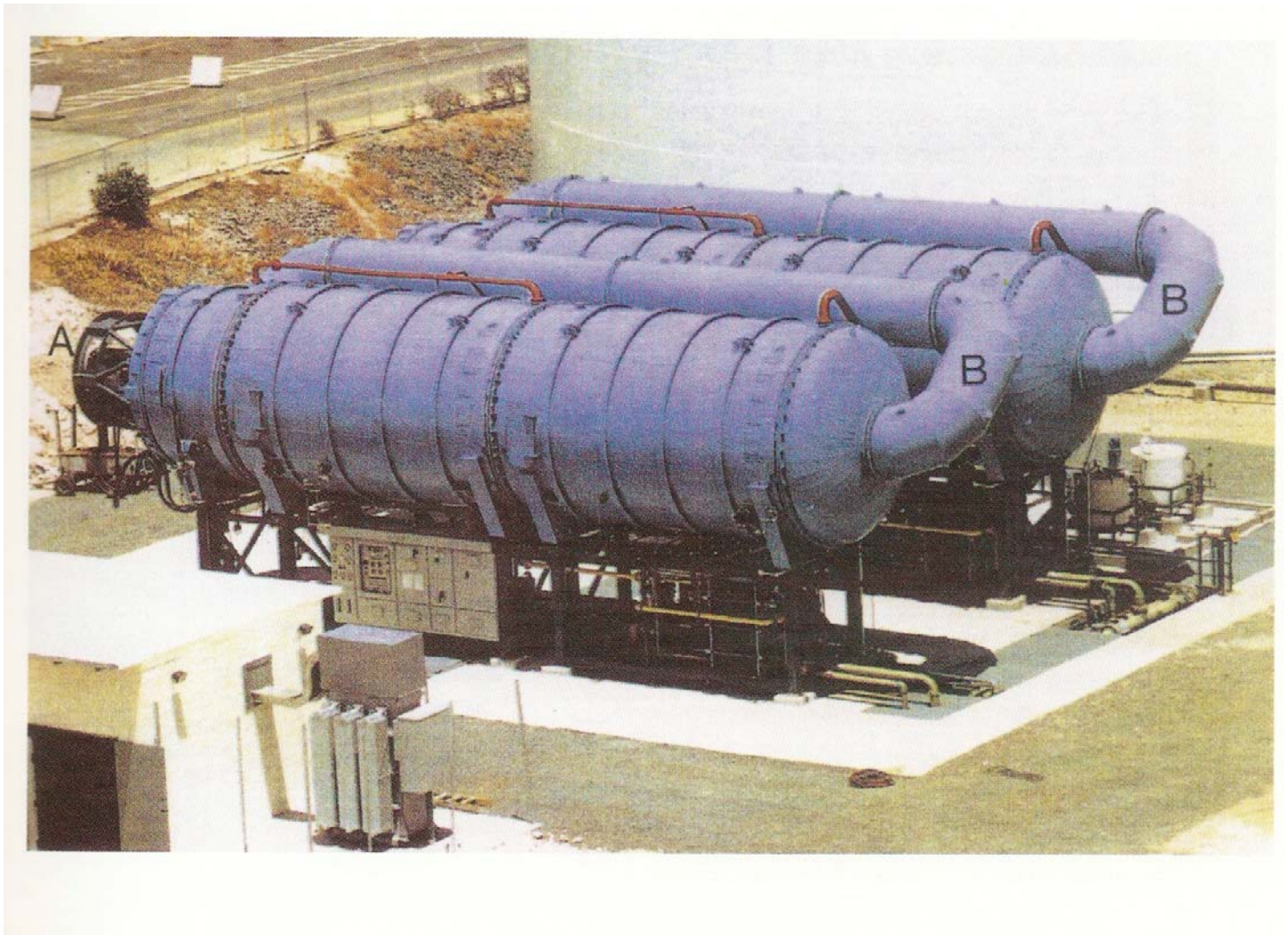
Σχήμα 7.3.Εγκατάσταση αφαλάτωσης με τη μέθοδο της μηχανικής επανασυμπίεσης ατμών. Τα εξατμιστήρια είναι πολλαπλών βαθμίδων με οριζόντιους σωλήνες κατερχόμενου υμένα. (I.D.E. TECHNOLOGIES Ltd)
