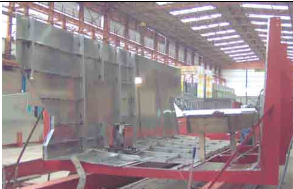
Εικόνα 7.6- Η χαλύβδινη ιδιοσυσκευή της Υπερκατασκευής έτοιμη σε φάση συναρμολόγησης επί των διμεταλλικών ελασμάτων
