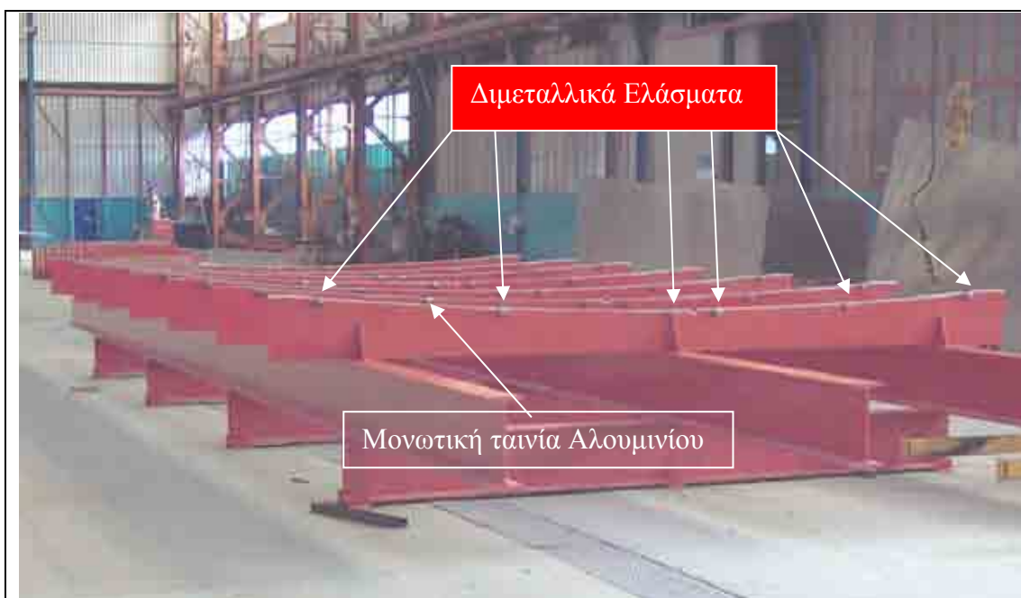
Εικόνα 7.4- Η χαλύβδινη ιδιοσυσκευή του πρωραίου τομέα S02 μετά τον χρωματισμό και την τοποθέτηση ταινίας αλουμινίου και διμεταλλικών ελασμάτων
