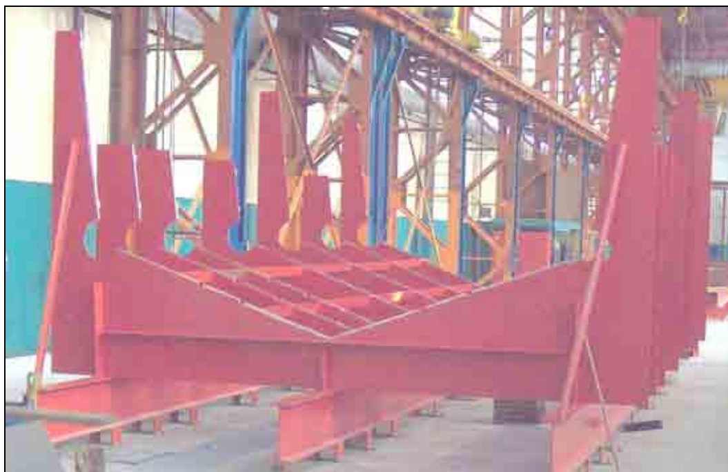
Σχήμα 5.8: Ιδιοσυσκευή Προκατασκευής Τομέα S01
