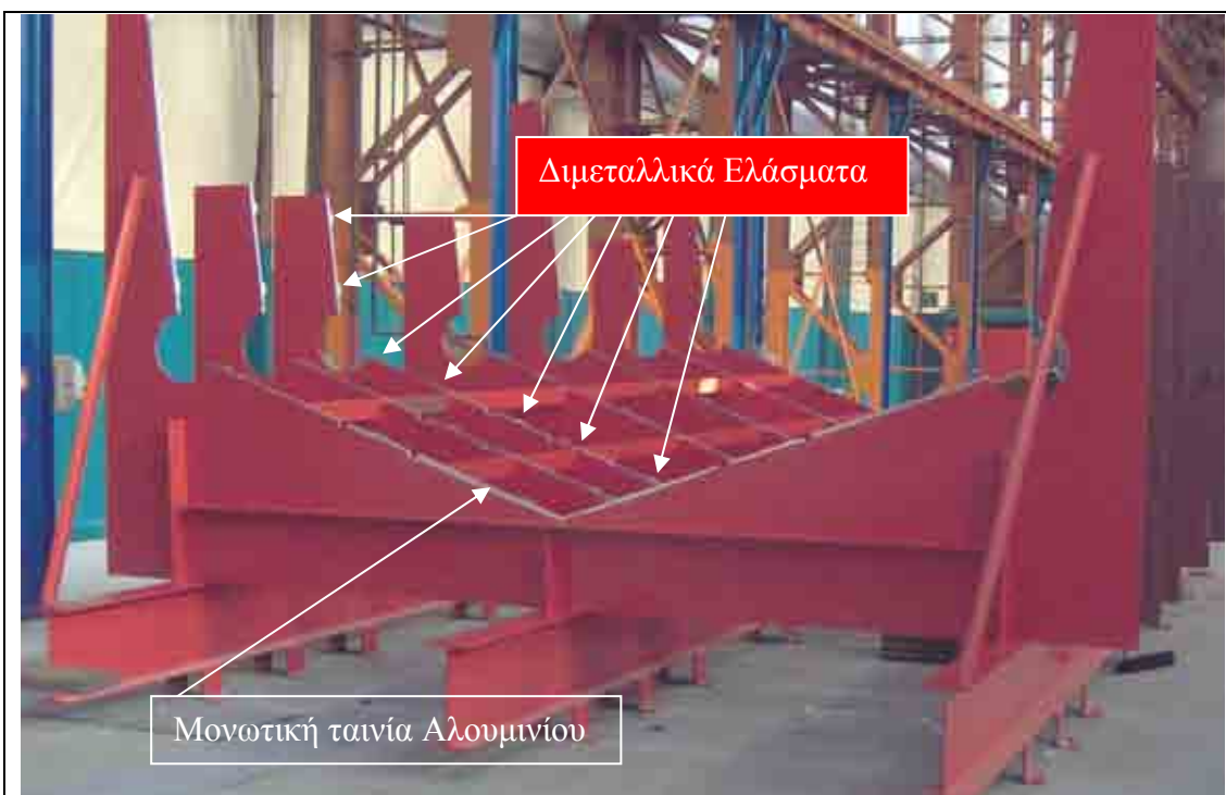
Εικόνα 7.3- Η χαλύβδινη ιδιοσυσκευή του πρυμναίου τομέα S01 μετά τον χρωματισμό και την τοποθέτηση ταινίας αλουμινίου και διμεταλλικών ελασμάτων
