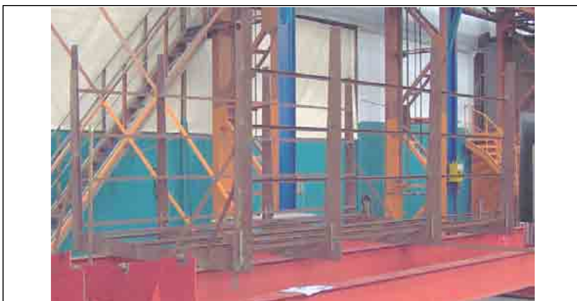
Εικόνα 7.5: Η χαλύβδινη ιδιοσυσκευή της Υπερκατασκευής κατά την κατασκευή της από χάλυβα
