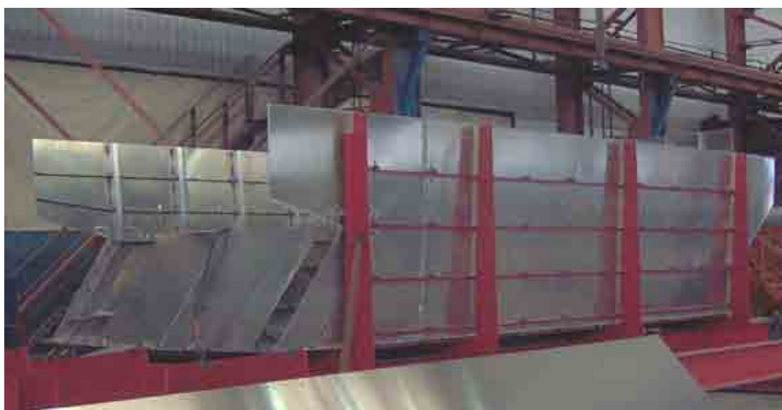
Σχ.5.15: Ιδιοσυσκευή Προκατασκευής Τομέα S03 και συναρμολόγηση σε ανάποδη θέση
