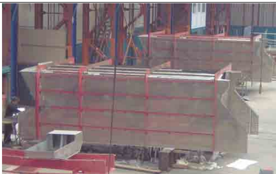
Εικόνα 7.7- Η χαλύβδινη ιδιοσυσκευή της Υπερκατασκευής ως ζυγός ανέγερσης της
