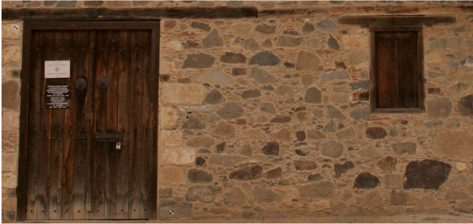
Εικόνα 2.2: Τμήμα τοίχου που είναι κτισμένος με αργολιθοδομή
