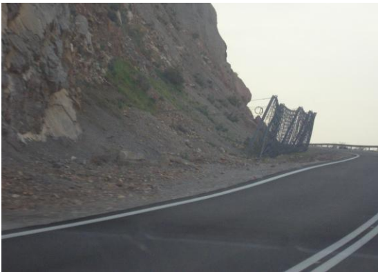
Εικόνα 3.5: Συρματοκιβώτια, Τοίχος αντιστήριξης και σύρματα, Συρμάτινος φράχτης, Τεχνικό σκελεπαστρο
