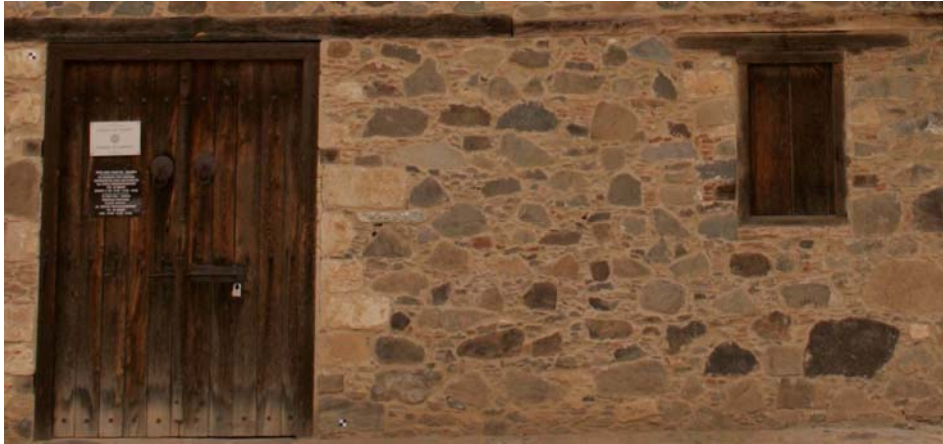
Εικόνα 2.2: Τμήμα τοίχου που είναι κτισμένος με αργολιθοδομή
