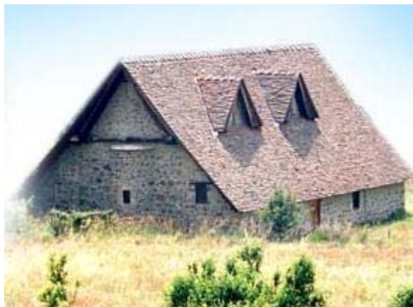
Εικόνα 2.4: Τριγωνικοί φεγγίτες που τοποθετήθηκαν το 1956
