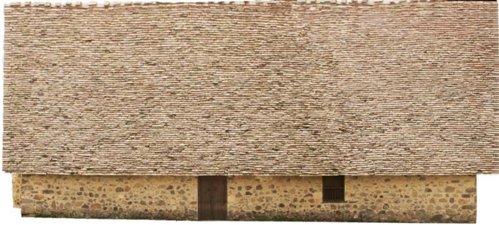
Εικόνα 6.19: Ορθοφωτογραφία της βόρειας όψης.
