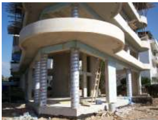
Εικόνα 10.11.: Υπό κατασκευή επαγγελματικό ακίνητο (Λεωφ. Βασ. Παύλου στην περιοχή του Ασκληπιείου Βούλας)
