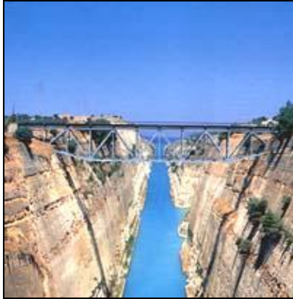
Εικόνα 2-5: Η Διώρυγα της Κορίνθου (Πηγή: http://hellas.teipir.gr )
