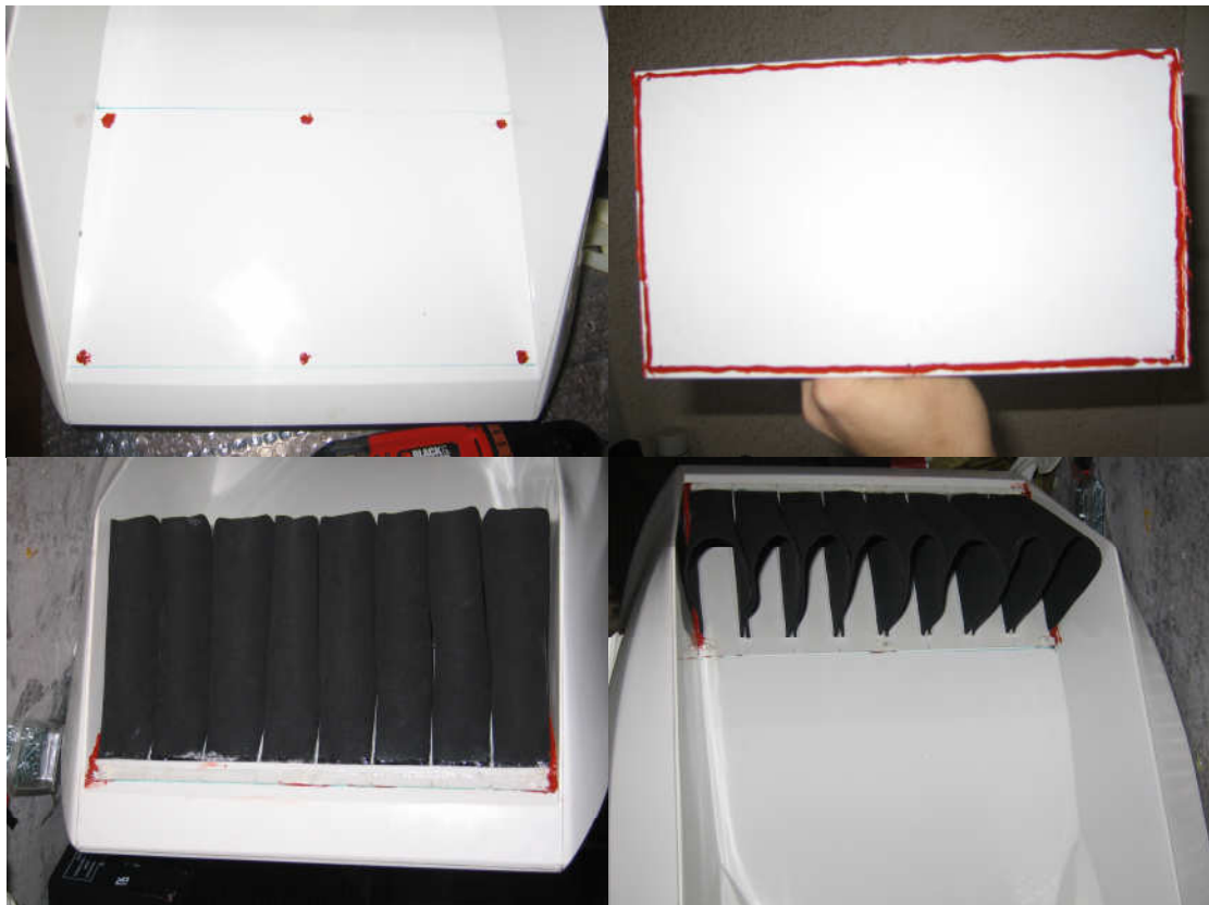
Σχήμα 2.18. Εγκατάσταση προραίας ποδιάς στη γάστρα.
