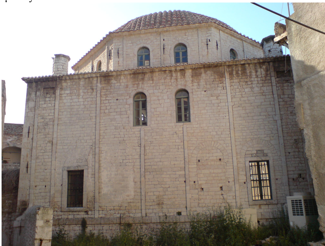
Φωτ 1.7 : Νότια όψη του Βουλευτικού
