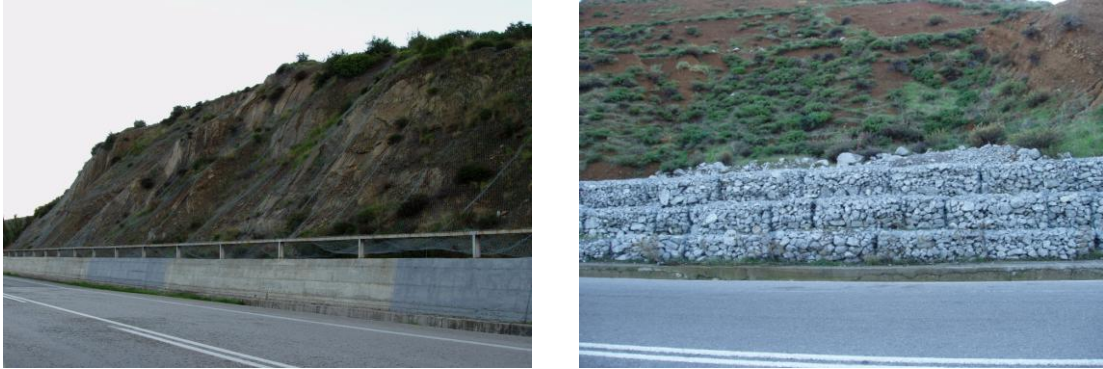
Εικόνα 2.2: Μέτρα αντιμετώπισης κατολισθητικών φαινομένων (Eurokinissi, 2003).
