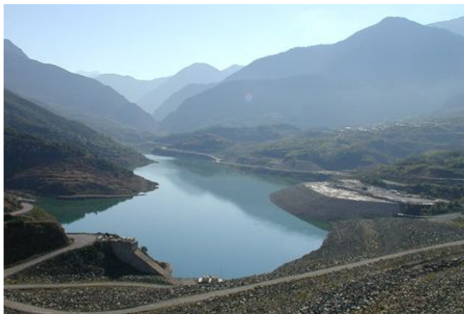
Εικόνα 4.1: Τεχνητή λίμνη Ευήνου
