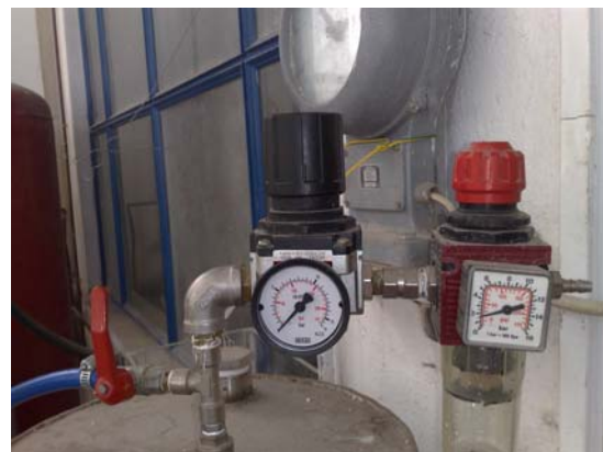
Εικόνα 3: Ρυθμιστής πίεσης στο θερμοσίφωνα
