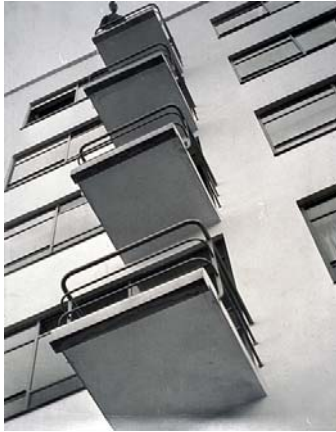
Εικ 191: Μπαλκόνια του κτιρίου διοίκησης
