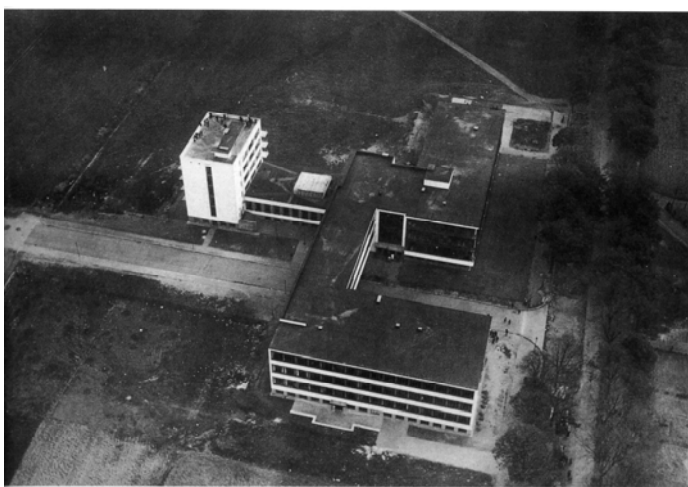
Εικ 190: αεροφωτογραφία των κτιρίων bauhaus στο Ντεσσάου.
