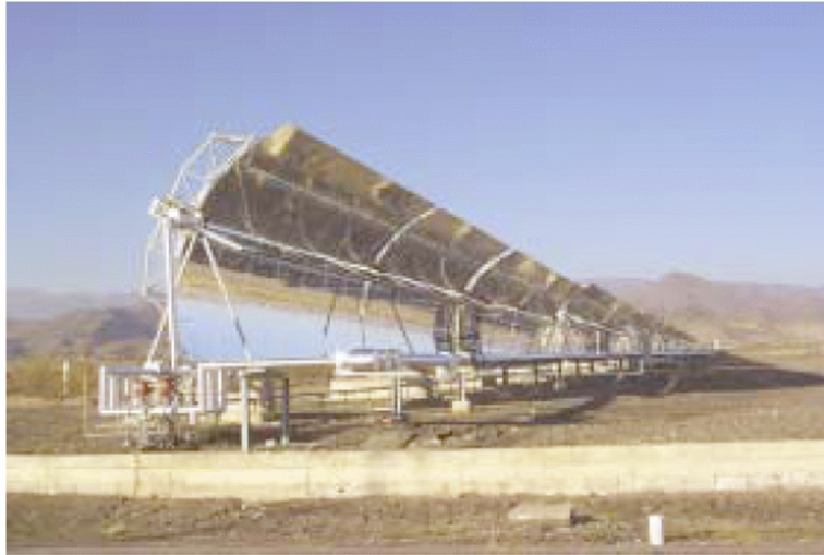
Σχήμα 5.2 Παραβολικοί συλλέκτες LS 3 της εταιρίας LUZ για άμεση παραγωγή ατμού (Αλμερία, νότια Ισπανία).
