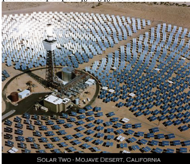
Σχήμα 5.3 Ο σταθμός SOLAR TWO.
