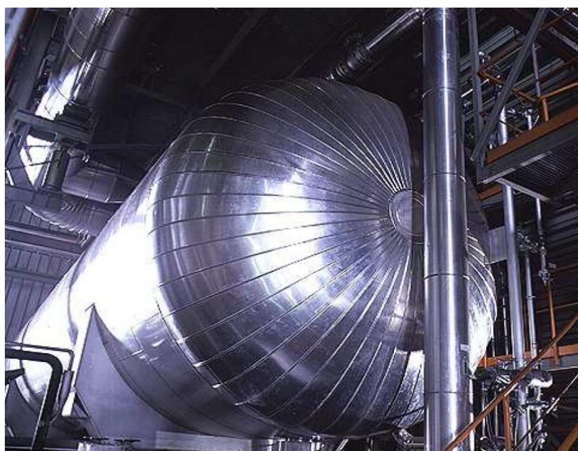
Εικόνα 4.1.13. Προθερμαντής κλειστού τύπου
