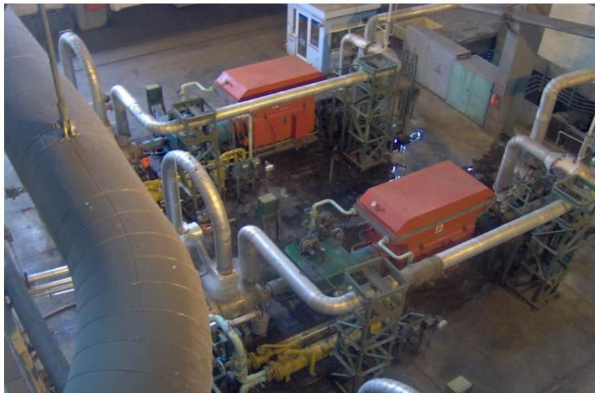
Εικόνα 4.1.9. Τροφοδοτικές αντλίες Α.Η.Σ. Αγίου Δημητρίου
