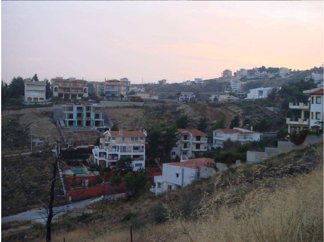
Φωτογραφίες 34, 35. Ογκώδη συγκροτήματα κατοικιών στη περιοχή του Ν. Βουζά (ΠΕ9). Μετά την πυρκαγιά το περιβάλλον υποβαθμίστηκε και αποκαλύφθηκαν τα αντιαισθητικά κτίρια.
