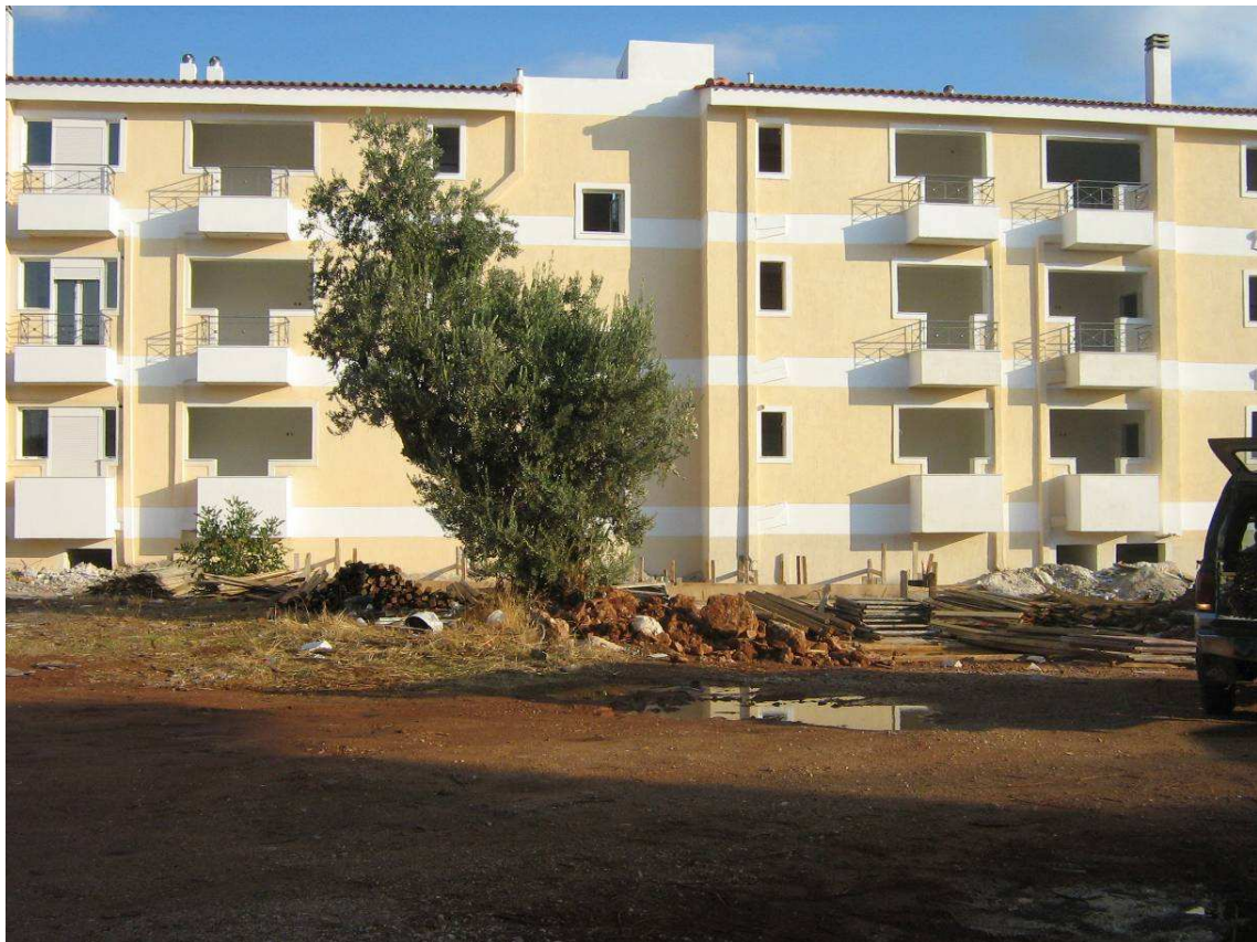
Φωτογραφίες 5, 6. Πολυκατοικίες υπό κατασκευή στην ΠΕ5 (πάνω από τη λεωφόρο Μαραθώνος). Ο γειτονικός ελεύθερος χώρος δεν είναι ακάλυπτος χώρος της ιδιοκτησίας που βρίσκεται η κατασκευή αλλά διπλανή άκτιστη ακόμη ιδιοκτησία
