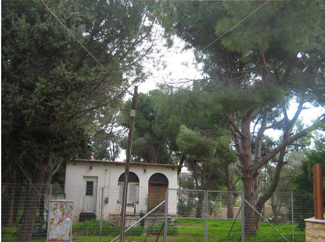
Φωτογραφίες 16, 17. Πολεοδομική Ενότητα 2. Το δρομάκι ήταν αρκετό για την εποχή που ανοίχτηκε και όταν παντού υπήρχαν μικρές κατοικίες όπως στην κάτω φωτογραφία. Δυστυχώς οι νέες μάντρες χτίζονται εκεί που υπήρχαν τα παλαιά συρματοπλέγματα χωρίς να παραχωρούνται τα ρυμοτομούμενα.
