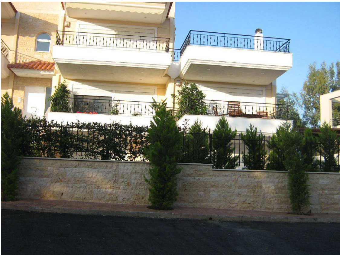
Φωτογραφίες 10, 11. Νέα συγκροτήματα κατοικιών στην ΠΕ 5, παραλιακά (επί της οδού Ποσειδώνος).
