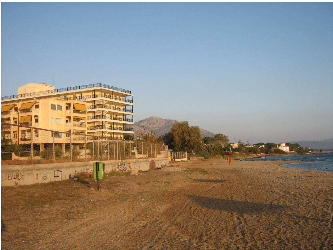
Φωτογραφίες 12, 13. Κατασκευές δεκαετίας 70 στο Ζούμπερι. Η κατασκευή στη κάτω φωτογραφία έχει μετατραπεί από το 2004 σε πολυτελή οίκο ευγηρίας.
