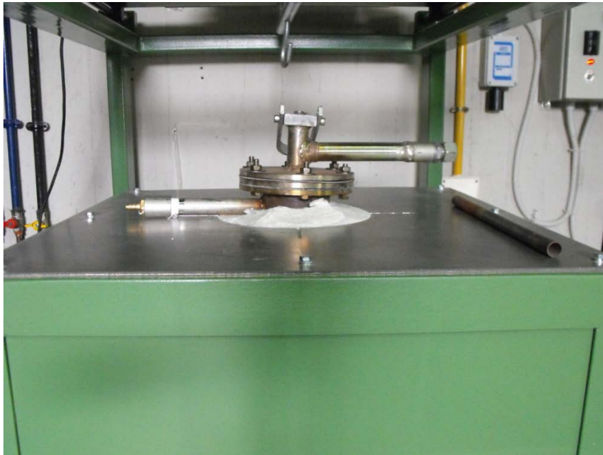
Εικόνα Α.11. Το πάνω άκρο του χαλύβδινου κυλίνδρου που περιέχει το δειγματοφορέα. Πάνω στο καμίνι αριστερά φαίνεται ο αγωγός των απαιρίων ο οποίος μπορεί και εξάγεται.
