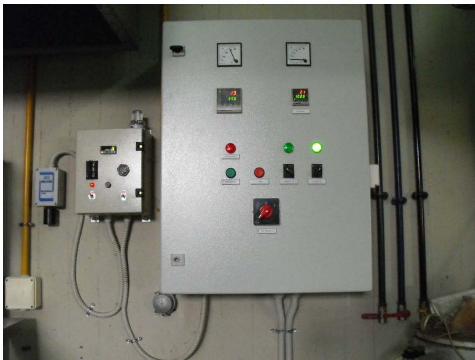
Εικόνα Α.4. Ο πίνακας ελέγχου-χειρισμού της λειτουργίας του καμινιού αναγωγικής φρύξης.
