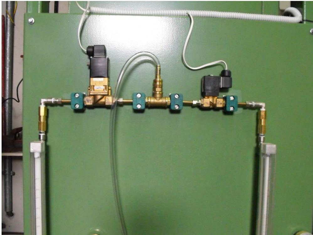
Εικόνα Α.20. Τα δύο ηλεκτρικά ροόμετρα του αζώτου αριστερά και του μονοξειδίου δεξιά.
