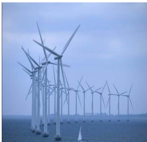
Εικόνα 2.6 Υπεράκτιο αιολικό πάρκο (EWEA, 2007)
