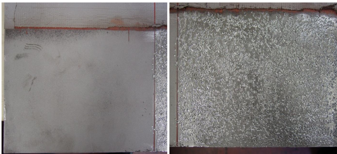
Σχήμα 3.10: Επιφανειακή κατεργασία χάλυβα με αμμοβολή και αεροματσάκονο αντίστοιχα
