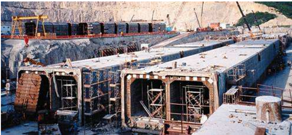
Εικ. 15 – Κατασκευή σπονδύλων σήραγγας στην ξηρά
