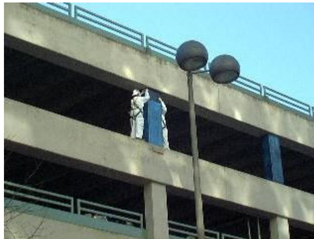
Ενίσχυση κατακόρυφου στοιχείου σκυροδέματος με χρήση ανθρακονημάτων
