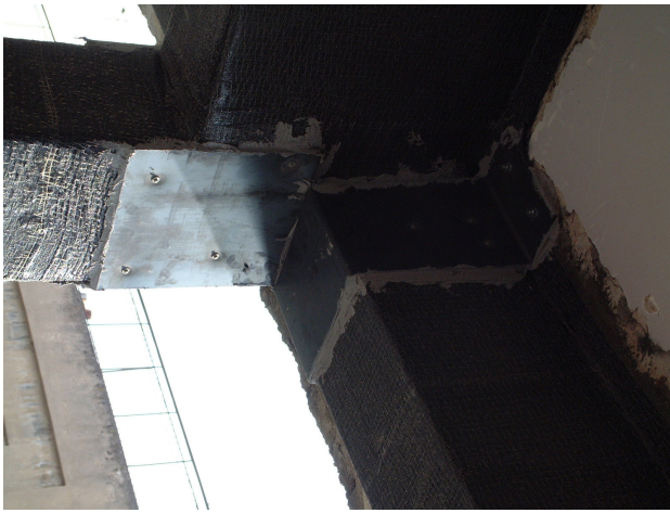
Ενίσχυση κόμβου σκυροδέματος με χρήση ανθρακονημάτων και μεταλλικών ελασμάτων
