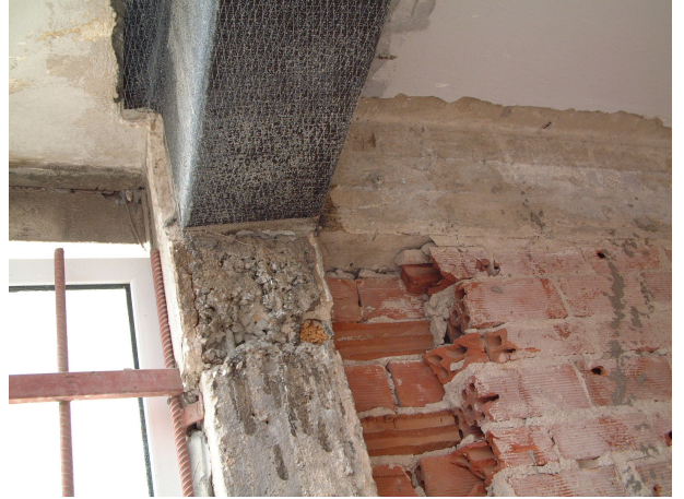
Ενίσχυση κόμβου σκυροδέματος με χρήση ανθρακονημάτων και μεταλλικών ελασμάτων
