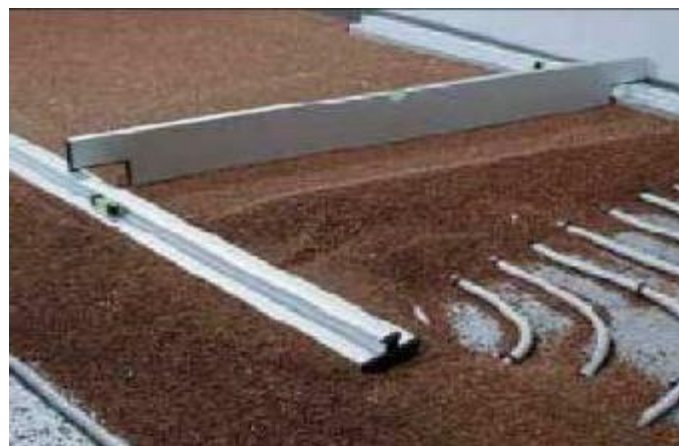
Σχήμα 2.16 Ενδοδαπέδια ηλεκτρική εγκατάσταση(PCM σε κόκκους)
