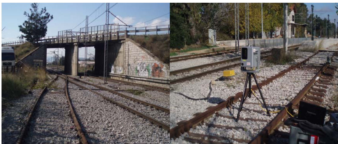
Εικόνα 3.4: Πρώτη θέση σάρωσης στην κάτω διάβαση της Δεκέλειας
