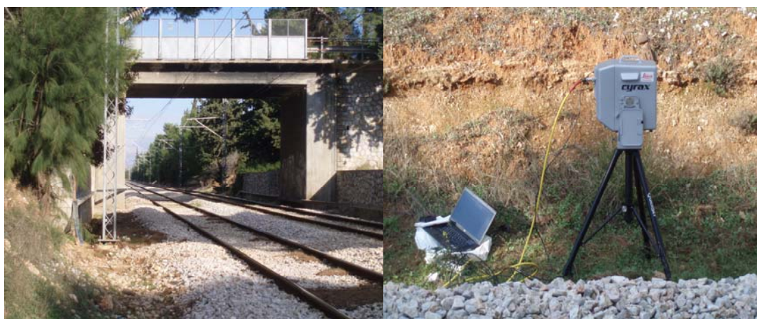
Εικόνα 3.6: Πρώτη θέση σάρωσης στην κάτω διάβαση της Βαρυμπόμπης
