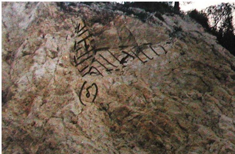
Εικόνα 5.22: Τυπική μορφή εκδηλωμένης σφηνοειδής αστοχίας.
