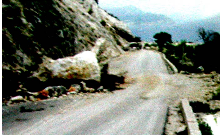
Εικόνα 5.4: Εκδηλωμένες βροχοπτώσεις και υφιστάμενοι ογκόλιθοι στη στέψη και στην ανάντη της στέψης περιοχής των ορυγμάτων (Τα βραχοτεμάχια είναι ιδιαίτερα ικανού όγκου, γωνιώδη και υγιή όσον αφορά στην ποιότητα της βραχόμαζας).
