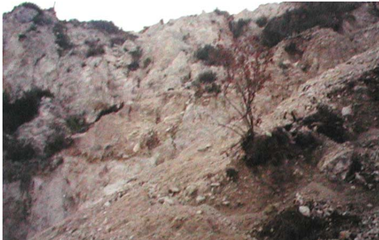
Εικόνα 5.7: Ετοιμόρροποι όγκοι βραχώμαζας λόγω του εντονότατου κατακερματισμού και της εδαφοποίησης του γεωυλικού στη θέση από Χ.Θ. 0+370 έως Χ.Θ. 0+390
