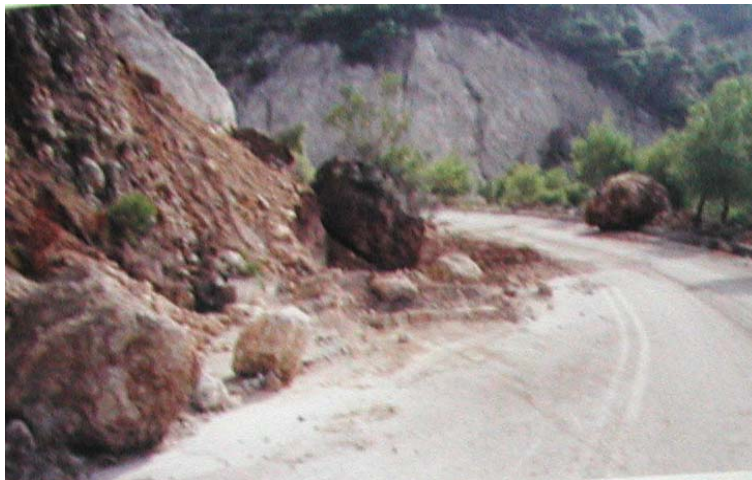
Εικόνα 5.23: Εκτεταμένες πτώσεις βραχοτεμαχίων, ασύνδετων ή τοπικά συνδεδεμένων με εδαφικό υλικό και ικανό συνήθως μέγεθος.
