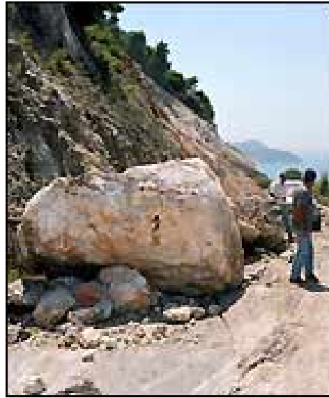
Εικόνα 3.3: Φωτογραφίες από τις αστοχίες των πρανών στη θέση Πευκούλια (οδός Τσουκαλάδες – Αγ. Νικήτα).
