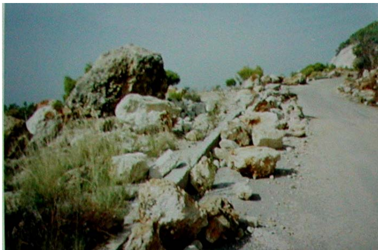
Εικόνα 5.16 : Εκτεταμένες βραχοπτώσεις με βραχοτεμάχη μικρού και ικανού όγκου
