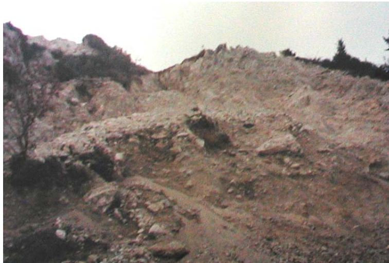
Εικόνα 5.5: Ετοιμόρροποι όγκοι βραχόμαζας λόγω του εντονότατου κατακερματισμού και της εδαφοποίησης του γεωυλικού στη θέση από Χ.Θ. 0+740 έως Χ.Θ. 0+770
