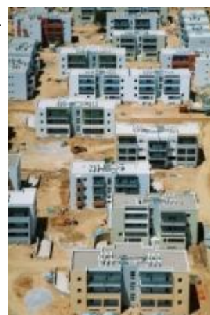
εικόνα 5.4, Ολυμπιακό Χωριό, ένα απέραντο εργοτάξιο
