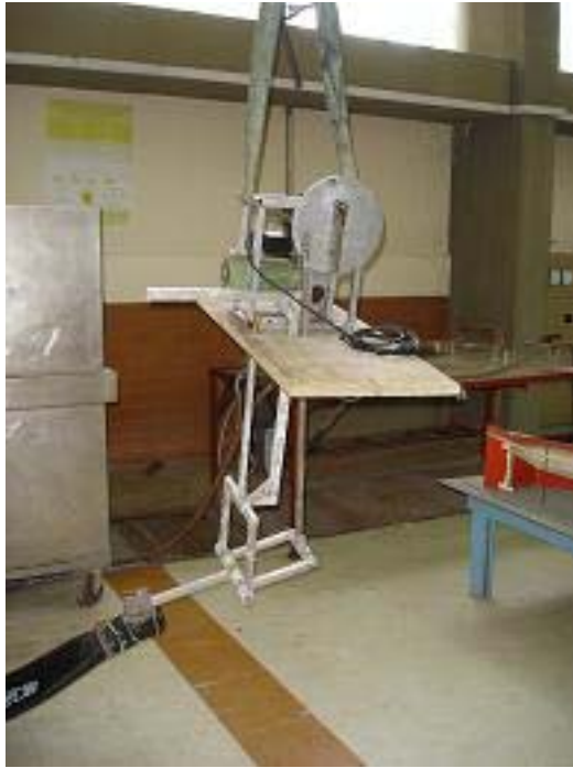
Σχ.4.9 Τοποθέτηση με γερανογέφυρα
