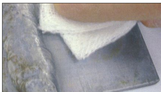
Εικόνες 4.22 έως και 4.25: Το ειδικό χημικό υγρό για την ουδετεροποίηση της επιφάνειας και η διαδικασία εφαρμογής του
