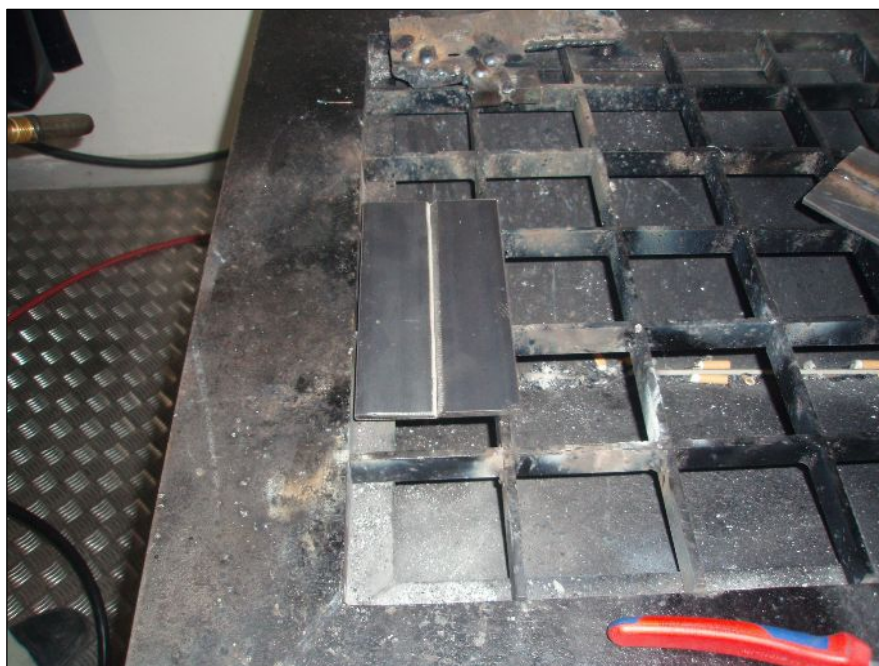
Εικόνα 4.4: Τοποθέτηση των ελασμάτων για την πραγματοποίηση της συγκόλλησης
