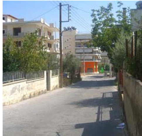
Εικόνες 16 και 17: Άποψη της οδού Ελαιών. Η κακή κατάσταση του οδοστρώματος και η έλλειψη πεζοδρομίων είναι εμφανής
