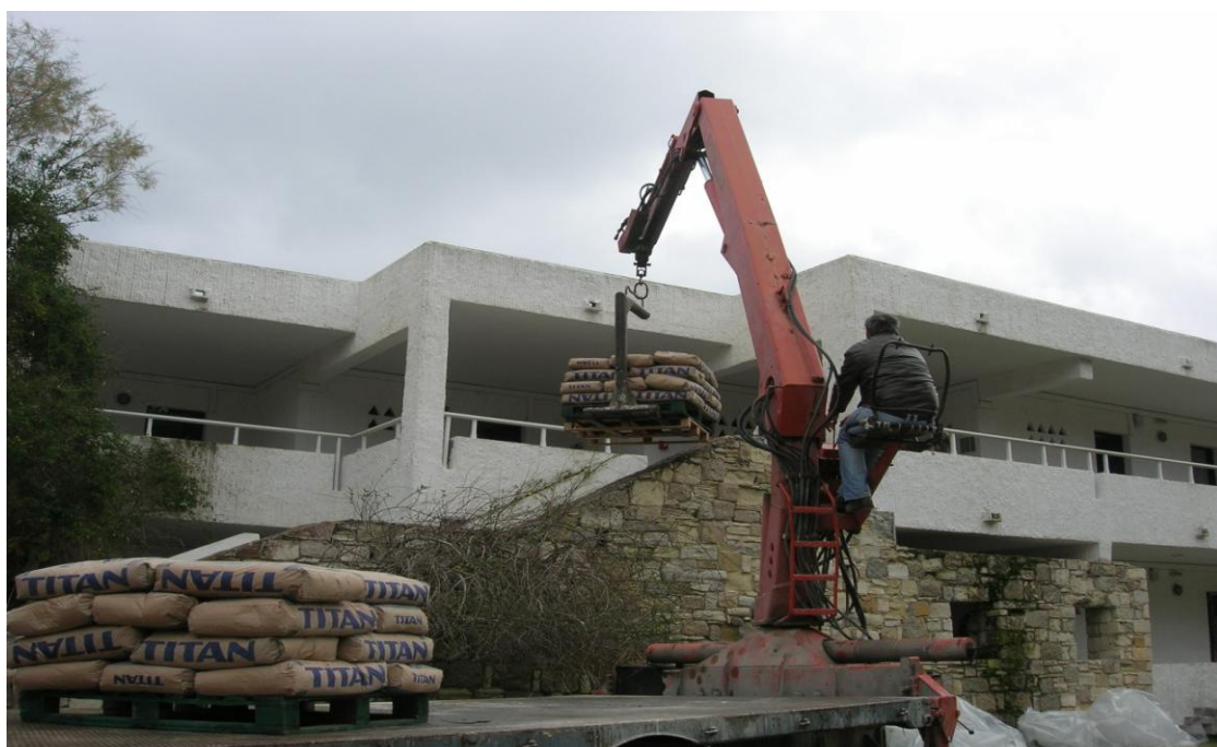
Φωτογραφία 3 : Η μεταφορά σάκων τσιμέντου με γερανό
