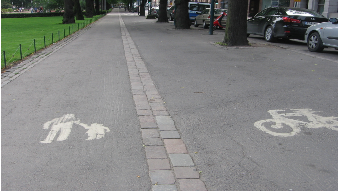
Εικόνα 3.10: Παράδειγμα ενιαίας επιφάνειας για πεζούς και ποδηλάτες διαχωρισμένη με χρήση διαφορετικού υλικού.
