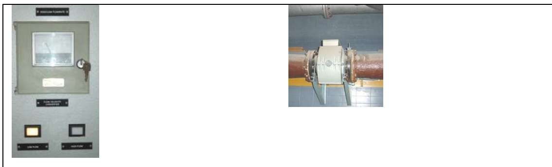
Εικόνα 3.12 Μετατροπέας (αριστερά) και μεταλλάκτης της παροχής (δεξιά)
