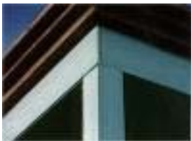
Σχήμα 1.38: Εφαρμογή εξηλασμένης πολυστερίνης ξυλοτύπων για θερμομόνωση στοιχείων οπλισμένου σκυροδέματος
