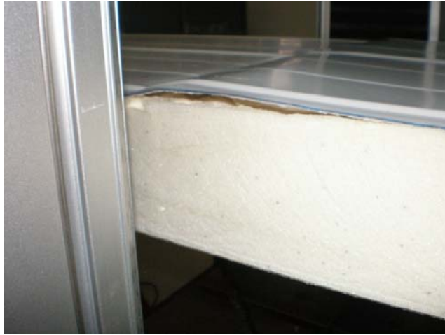
Σχήμα 5.45: Αστοχία δοκιμίου επίπεδου πάνελ ,με D= 80\text{mm} και L_p = 2000\text{ mm} , που καταπονήθηκε σε Simulated central support test. Είναι εμφανής οι πτυχώσεις, που έχουν δημιουργηθεί στο άνω φύλλο χάλυβα καθώς και η αποκόλληση της άνω επιφάνειας του χάλυβα από τον πυρήνα πολυουρεθάνης.
