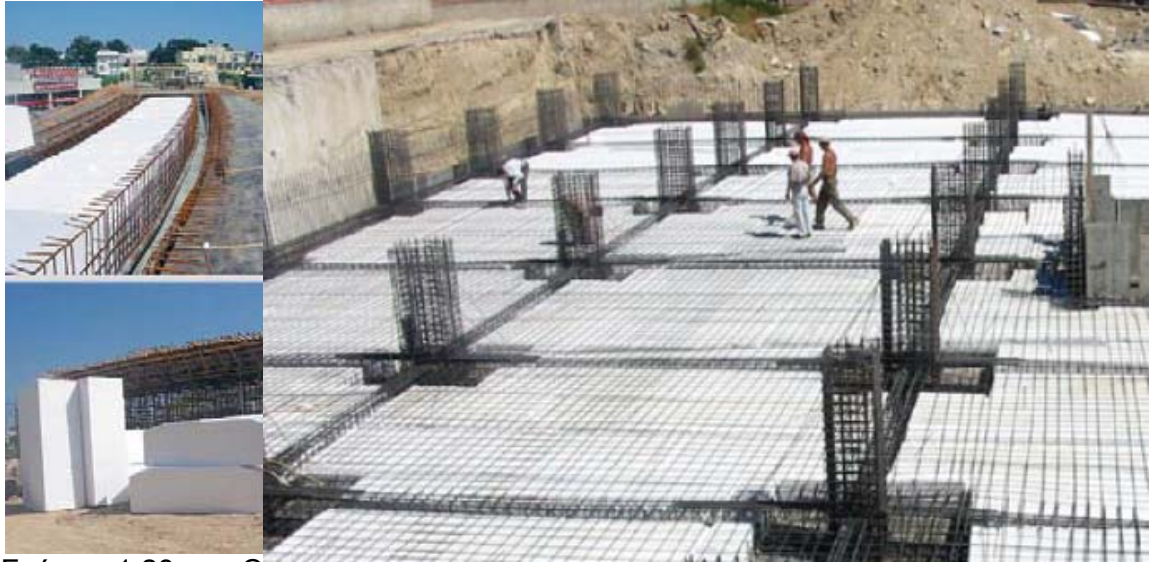
Σχήμα 1.28 : Θερμομόνωση στοιχείων από σκυρόδεμα με διογκωμένη πολυστερίνη
