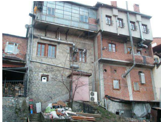
Εικόνα 15: Ανεπίχριστες Τοιχοποιίες, Αεραγωγοί, Κλείσιμο Βεράντας [Πηγή: Προσωπικό Αρχείο Χ. Καλογήρου]
