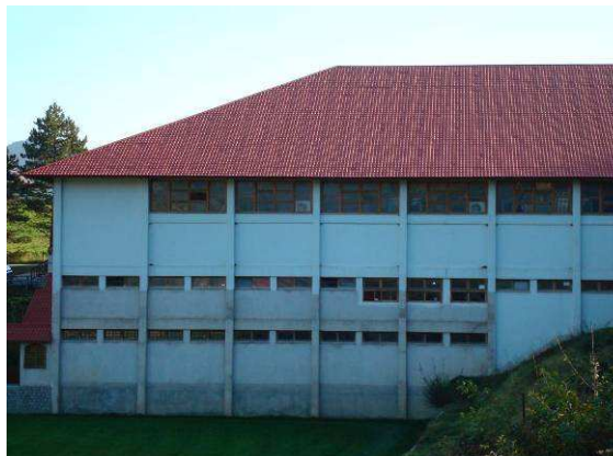
Εικόνα 17: Κτίριο Μεγάλου Μεγέθους-Όγκου από Οπλισμένο Σκυρόδεμα [Πηγή: Προσωπικό Αρχείο Σ. Γιαννακοπούλου]
