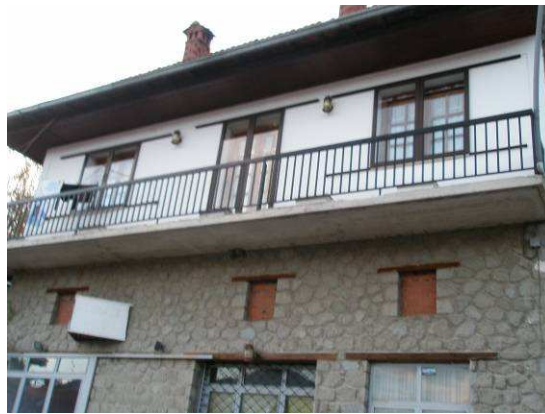
Εικόνα 16: Χρήση Δεύτερων Κουφωμάτων από Αλουμίνιο και Εμφανές Κλείσιμο Φεγγιτών [Πηγή: Προσωπικό Αρχείο Χ. Καλογήρου]
