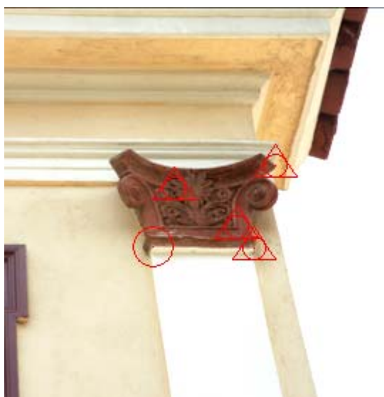
Εικόνα 3.10 Θέση φωτοσταθερών στο κιονόκρανο
