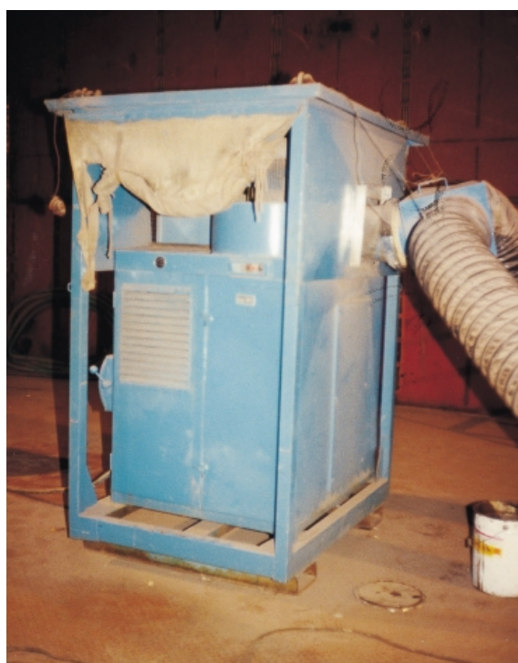
Εικόνα 4.14- Εγκατάσταση αφύγρανσης αέρα [26]
