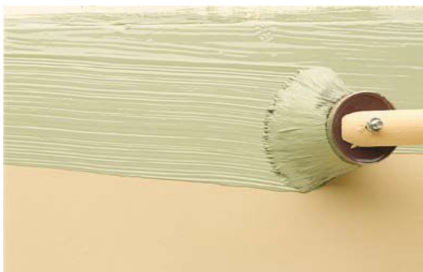
Εικόνα 4.10 - Η χρήση στρογγυλού πινέλου συνιστάται στις εργασίες χειρός [26]
