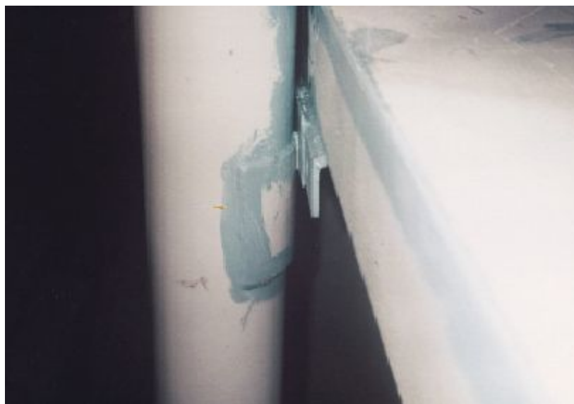
Εικόνα 3.16 – Τεχνική μερικής επικάλυψης με λωρίδες ( stripe-coats ) [26]
