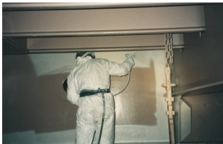
Εικόνα 4.12 - Η επιστρωση με ψεκασμό απαιτεί σωστή προεργασία, εκπαίδευση και τήρηση των διατάξεων ασφάλειας [26]
