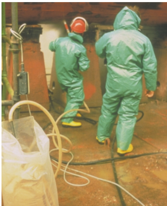
Εικόνα 4.7 - Εργασίες υδροβολής (αριστερά) και υδροεκτόξευσης (δεξιά) [26]
