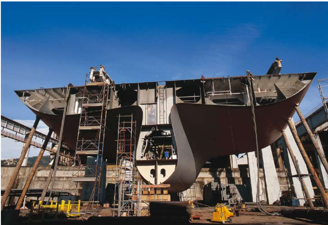
Εικόνα 6.1 - Η μεγάλη πολυπλοκότητα της κατασκευής επιβάλλει τη σωστή οργάνωση του ναυπηγείου [51]
