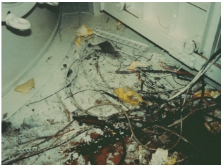
Εικόνα 4.1 - Ρυπασμένη επιφάνεια, ακατάλληλη για βαφή [26]
