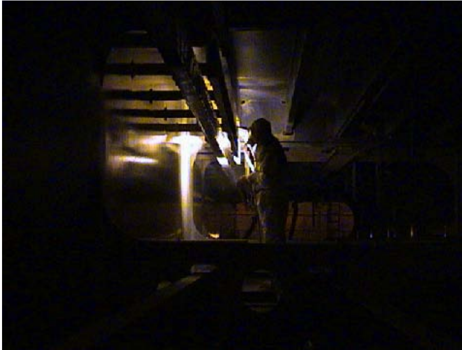
Εικόνα 3.19 - Ο φωτισμός των δεξαμενών έρματος είναι πάντα σημαντικό στοιχείο των επιθεωρήσεων [42]
