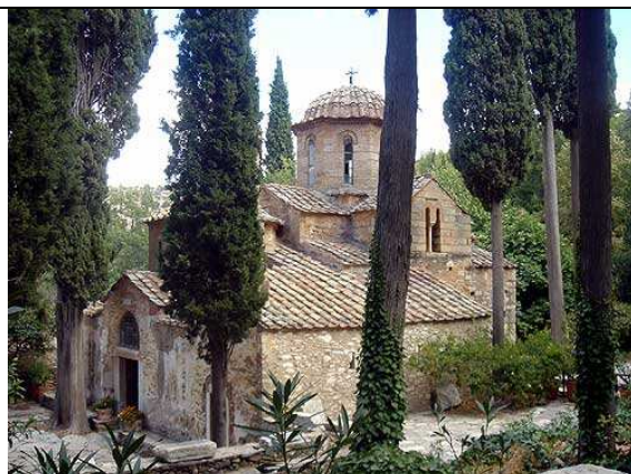
Εικόνα 162: Εξωτερική άποψη της Μονής Καισαριανής
