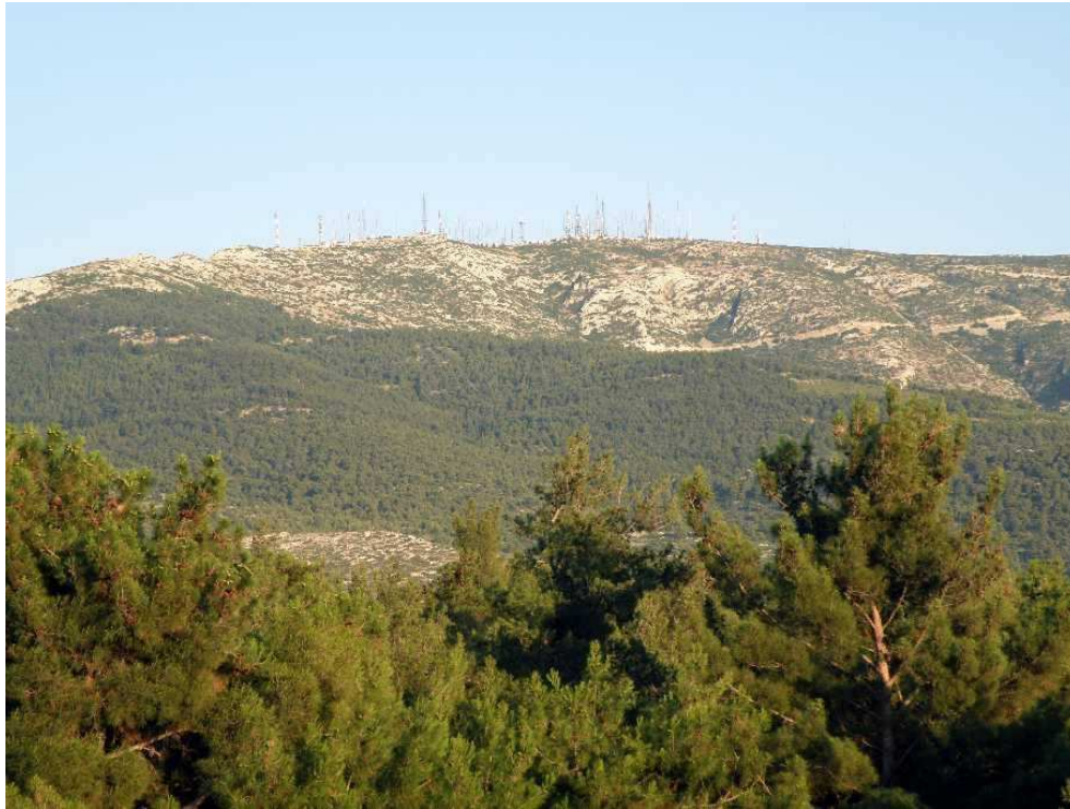
Εικόνα 192: Η καταστροφή του τοπίου λόγω κεραιών
