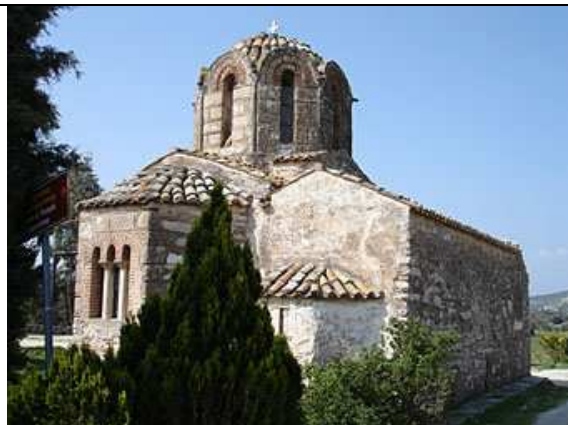
Εικόνα 183: Παναγία Μεσοσπορίτισσα στους Εννέα Πύργους. Αποψη από βορειοανατολικά. Διακρίνεται ο αθηναϊκός τρούλος και μέρος του καλού πλινθοπερίκλειστου συστήματος τοιχοποιίας του, όπως και στην κόγχη του Ιερού. (Φωτογραφία: Ν. Κοκκινάκης)
