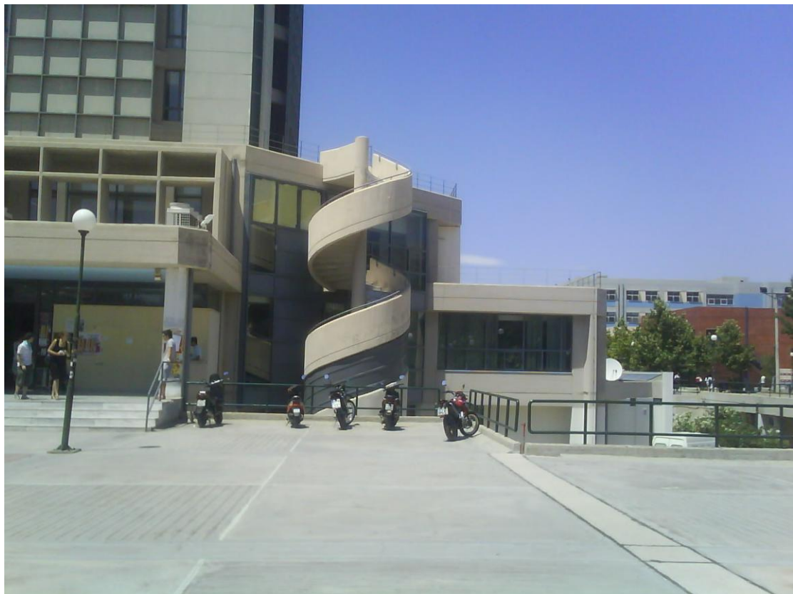
Το κλιμακοστάσιο της Βιβλιοθήκης του Ε.Μ.Π. Φαίνεται καθαρά η ενελικτική επιφάνεια.
