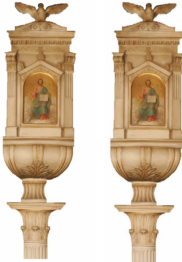
Εικόνα 8. 6: Ορθοφωτογραφία όπως προκύπτει από την επίθεση τμήματος διαφορετικής ορθοφωτογραφίας και μετά την εξομάλυνση των σημείων σύνδεσης
