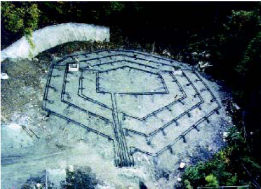
Σχήμα 4.5 : Ο εγκατεστημένος βράχος – δεξαμενή
