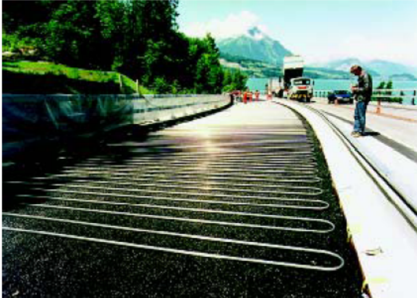
Σχήμα 4.3 Προχρωματισμένα υλικά από χρώμιο χρησιμεύουν σαν σωληνώσεις θερμότητας
