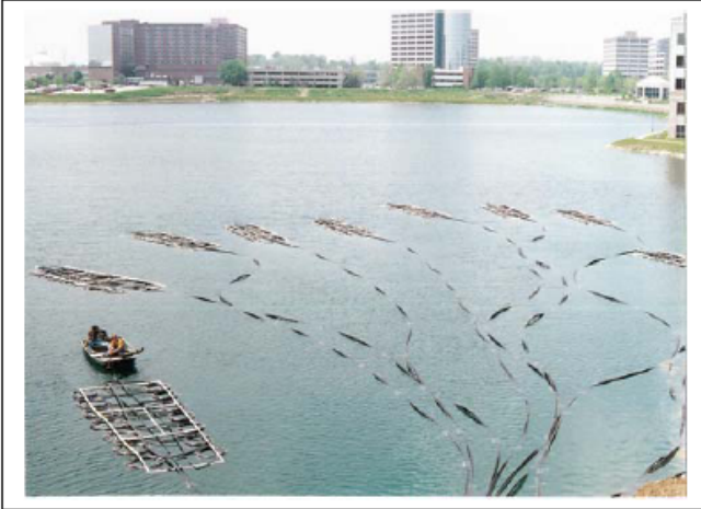
Σχήμα 3.25 Εγκατάσταση βρόγχου λίμνης
