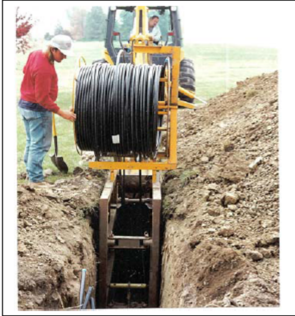
Σχήμα 3.21 Εγκατάσταση Οριζόντιου Βρόγχου
