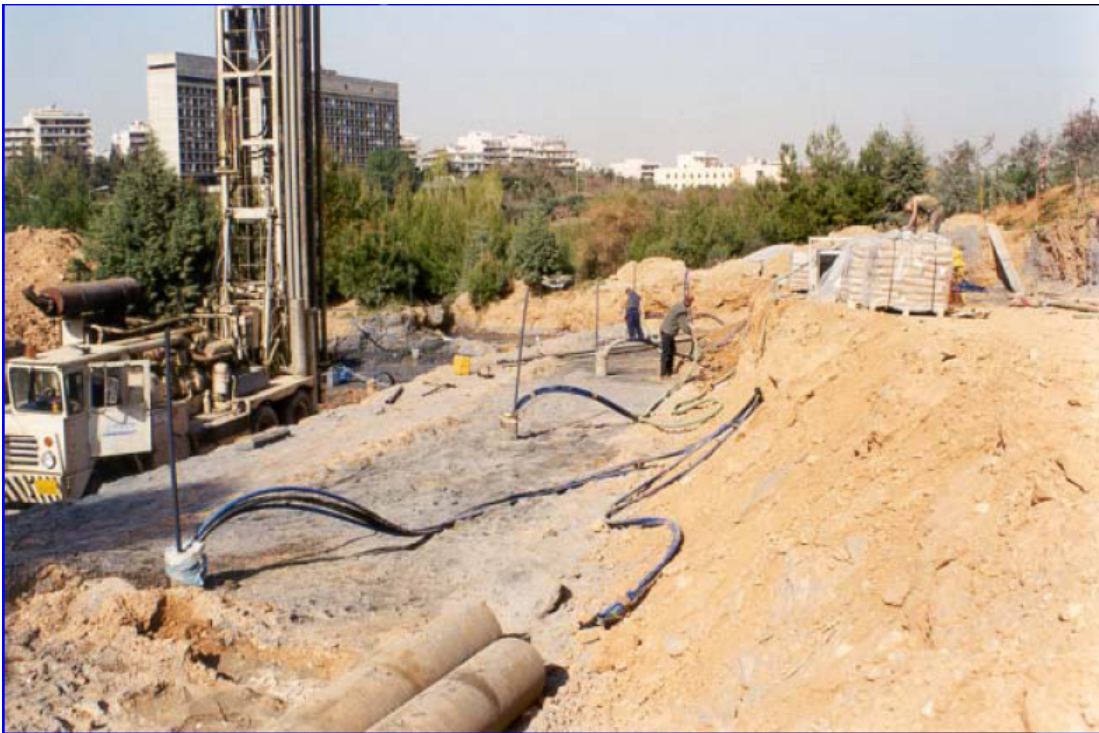
Σχήμα 4.1 Διαδικασία εγκατάστασης των γεωθερμικών εναλλακτών στην Πολυτεχνειούπολη
