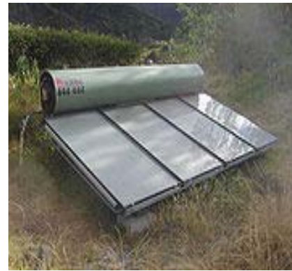
ΕΙΚΟΝΑ 4.1: Ηλιακό σύστημα παραγωγής θερμού νερού (Ηλιόθερμο )
