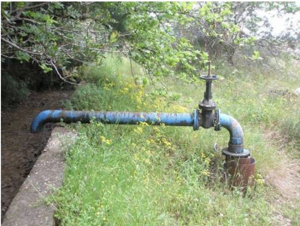
Φωτογραφία 4: Σύστημα τροφοδοσίας ανοικτών αγωγών για άρδευση
