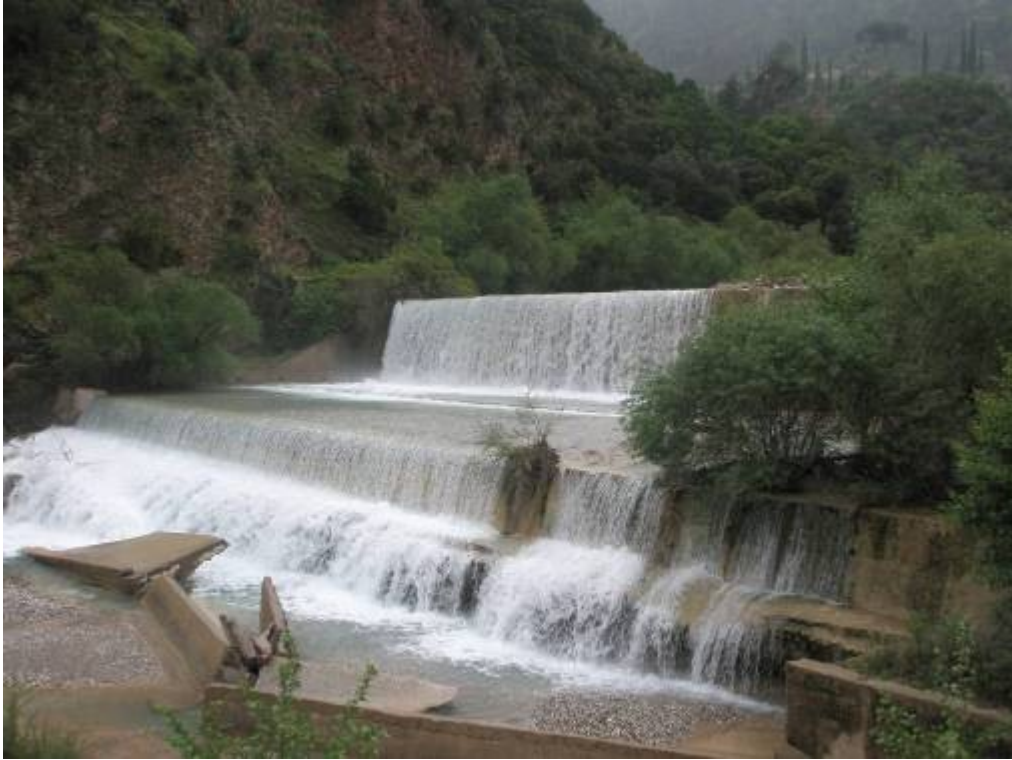
Φωτογραφία 1: Υπάρχων αναβαθμός υδροληψίας στον ποταμό Σελινούντα
