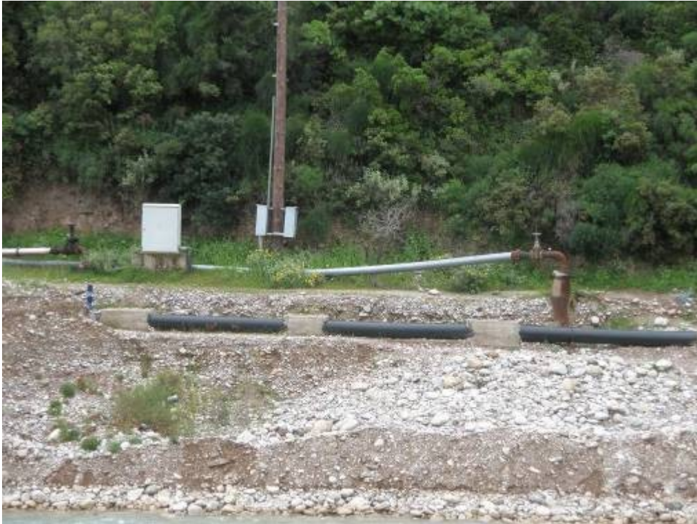
Φωτογραφία 3: Σύστημα υδροληψίας παρόχθια του ποταμού
