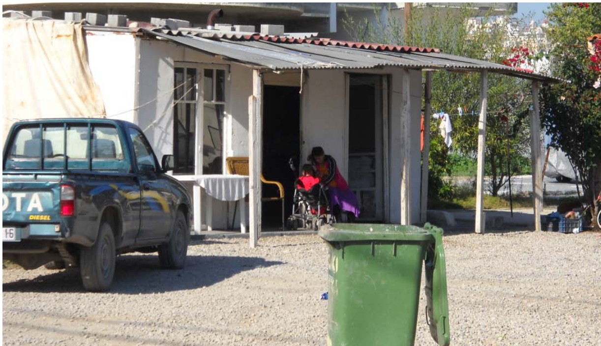
Εικόνα 5-14: Κέλυφος τύπου ελενίτ στον οικισμό Βλυχού (Λήψη συγγραφέα)
