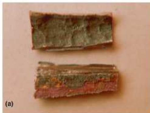
(a) Φωτογραφία 8.10-επικαθίσεις της εσωτερικής επιφάνειας του σωλήνα της μονάδας 1
