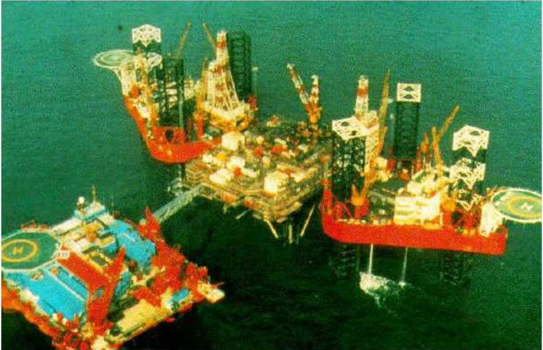
Φωτογραφία9.17-πλατφόρμα φυσικού αερίου στο Morcambe Bay στο Ηνωμένο Βασίλειο της οποίας οι χαλύβδινες βάσεις είναι επενδεδυμένες με κράμα C70600
