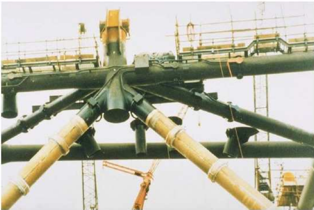
Φωτογραφία 9.19-επικάλυψη χαλύβδινων ελασμάτων με C70600 με τη μέθοδο sheathing σε βάσεις πλατφόρμας φυσικού αερίου στο Morecambe Bay
