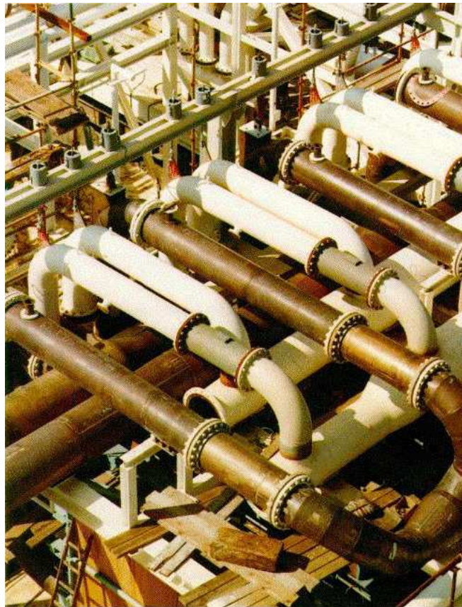
Εικόνα 2.8-ψυκτικό δίκτυο απο κράμα 90-10
