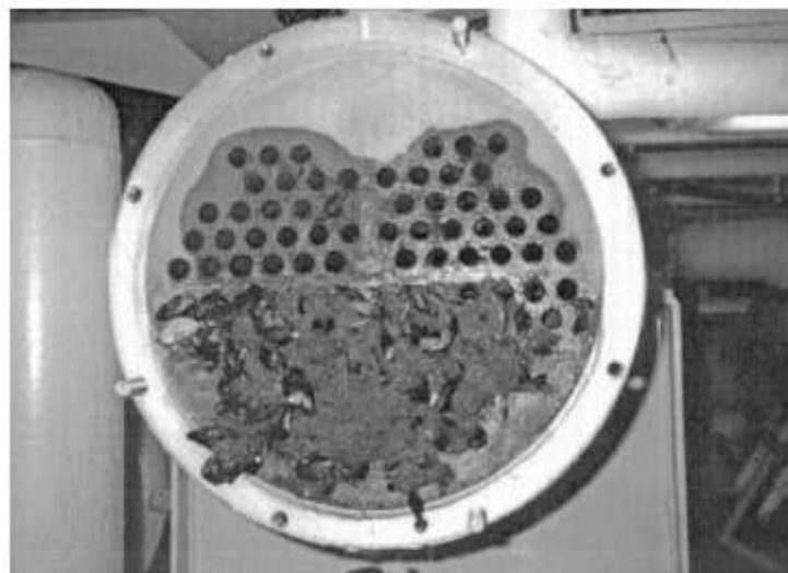
Φωτογραφία 8.24-ζωντανοί θαλάσσιοι οργανισμοί σε σωλήνα ο οποίος ήταν σε λειτουργία για μεγαλύτερο χρονικό διάστημα χωρίς καθαρισμό σε σύγκριση με το σωλήνα της φωτογραφίας 8.23
