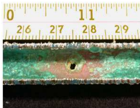
Φωτογραφία 8.15-τρύπα σε σωλήνα από C71500 εξαιτίας μικροβιακής διάβρωσης
