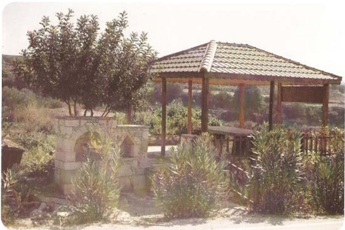
Εικόνα 1: Κατασκευή μικρού στεγάστρου βρύσης, καθώς και φύτευση του περιβάλλοντα χώρου. [Πηγή: Τμήμα Αναδασμού, 2005]
