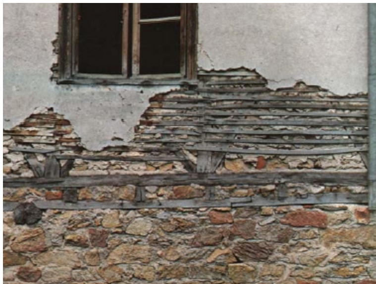
Εικόνα 103 Μπαγδατί με καρφωτές πήχεις & υποκείμενη αργολιθοδομή
