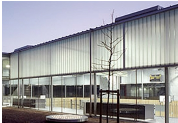
Εικόνα 82 Όψη κτιρίου το οποίο διαθέτει διαφανή θερμομόνωση
