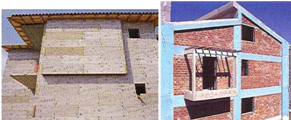
Εικόνα 29 Ολική εξωτερική θερμομόνωση
