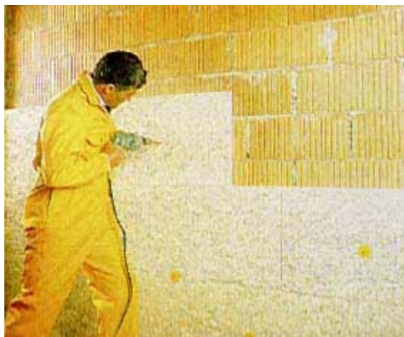
Εικόνα 28 Εσωτερική θερμομόνωση τοίχου
