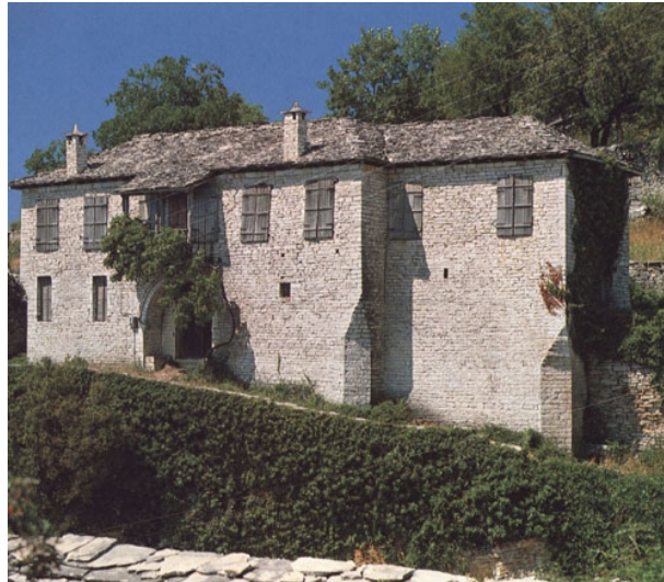
Εικόνα 117 Βίτσα: Σπίτι «δυτικού τύπου» (αυστηρός όγκος και λίγα παράθυρα)
