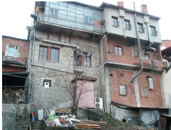
Εικόνα 174 Ανεπίχριστες τοιχοποιίες, αεραγωγοί, κλείσιμο θεράντας
