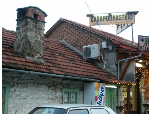
Εικόνα 172 Επιγραφές κακής αισθητικής και συσκευή κλιματισμού στην όψη καταστήματος
