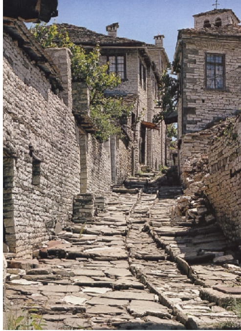
Εικόνα 116 Καλντερίμι στο Δίλοφο
