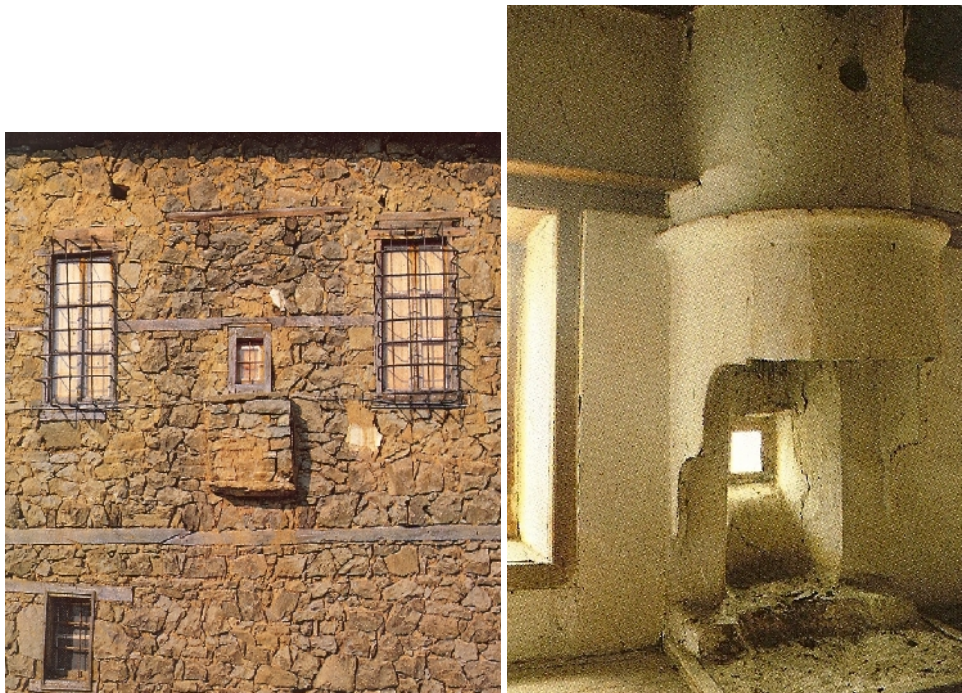
Εικόνα 167 Τοιχοποιία με ξυλοδεσιές και φεγγίτης μέσα στην φούσκα του τζακιού
