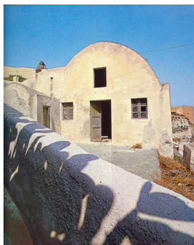
Εικόνα 132 Φοινικιά: κτίσμα που διατηρεί εξωτερικά τη μορφή του θόλου και τη διάταξη ανοιγμάτων στην πρόσοψη.
