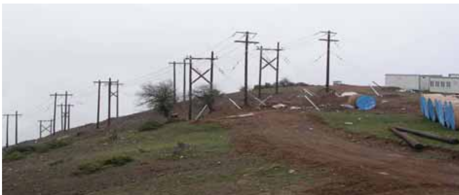
Εικόνα 15: Διπλή γραμμή Μ.Τ. βαρέως τύπου
