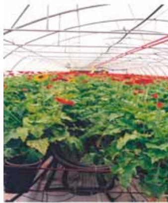
Εικόνα 20: Θέρμανση θερμοκηπίου από γεωθερμική ενέργεια Πηγή: http://www.ypan.gr/ape/files/mythoi-geothermia.pdf
